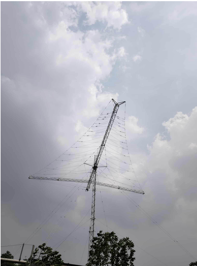
Figure 8: RRI Cimanggis 9690 rotatable log periodic antenna.
