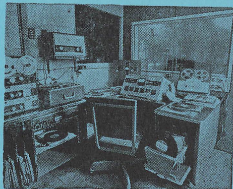
Control maestro en los estudios de la emisora, General Elizalde No. 112. Consola Gates, compresor de modulación, una grabadora profesional marca Roberts y dos portátiles marca Ampex y Phillips. La mesa de control cuenta además con brazos reproductores de sonido y tornamesas profesionales.
